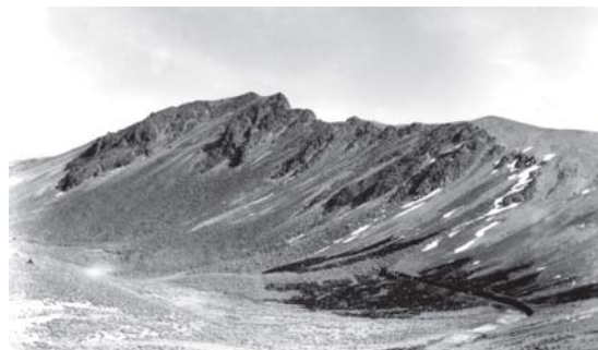
Arriba: Aspecto de la construcción de la carretera al cráter por debajo de los Picos Heilprin, ca. 1933 (anónimo).
